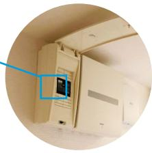
1-4 ①運転ランプと②発電電力表示ランプ [kW] が点灯することを確認する。
